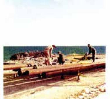
KIBRIS TÜRK PETROLLERİ DENİZ TERMİNALİ İNŞAATI
